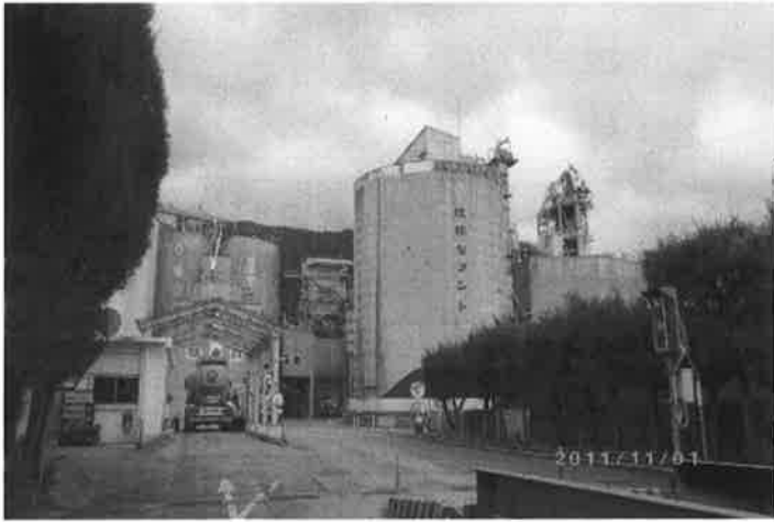
11月1日 午前 琉球セメント株式会社屋部工場 視察
