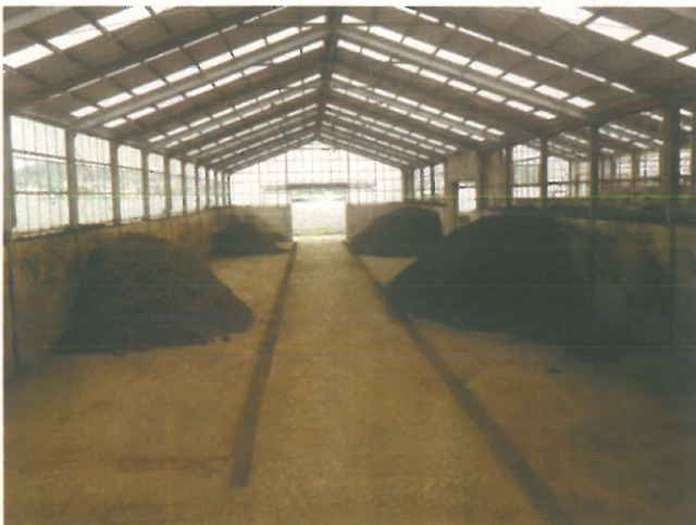
堆肥センターの中の様子（完成まえの状態）
