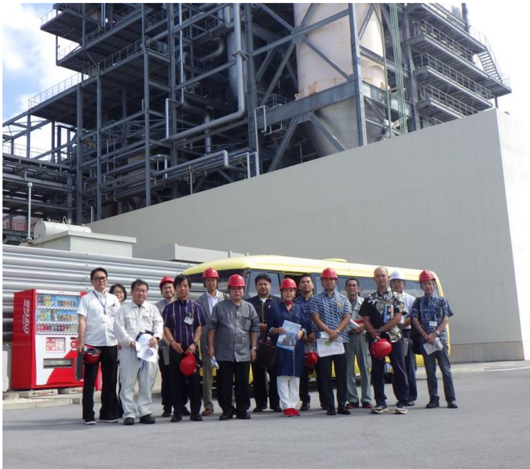
中城バイオマス発電所（沖縄うるまニューエナジー株式会社）
