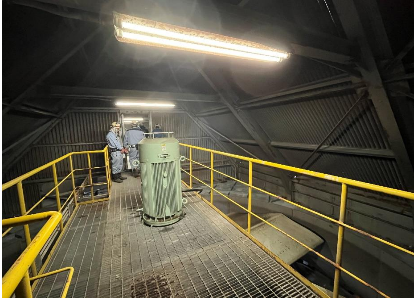
① No.1タービン排気復水器内部状況
