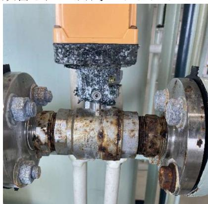
図-5 金属部の腐食-2
