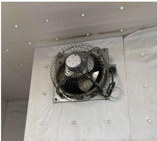
図-7 換気扇の腐食（プロワ室）
