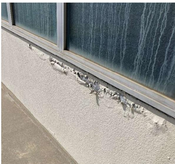
図-9 外壁仕上の膨れ・剥がれ
