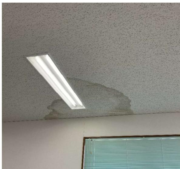
図-10 天井雨漏り（原因調査、張替）
