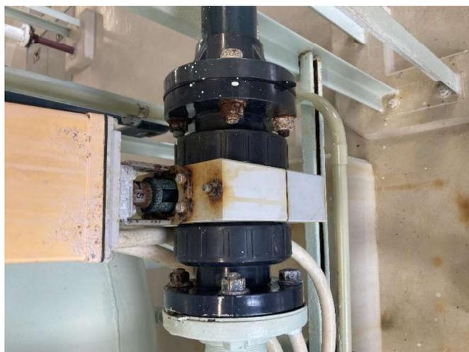
図-2 配管固定金具の腐食状況-2
