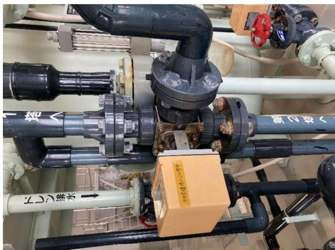
図-1 配管固定金具の腐食状況-1
