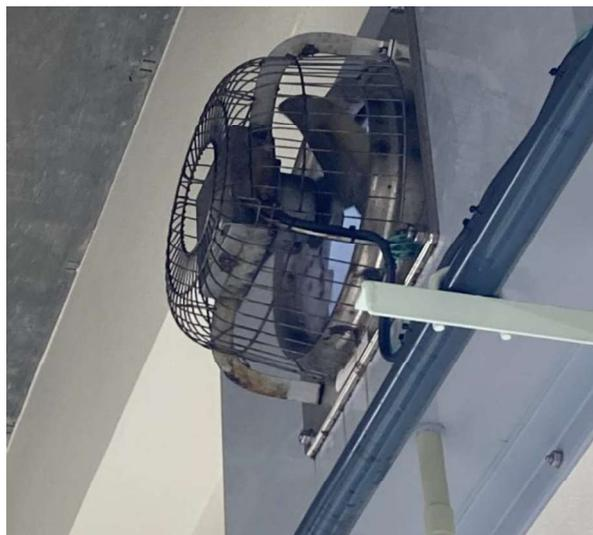
図-8 換気扇の腐食（処理室）
