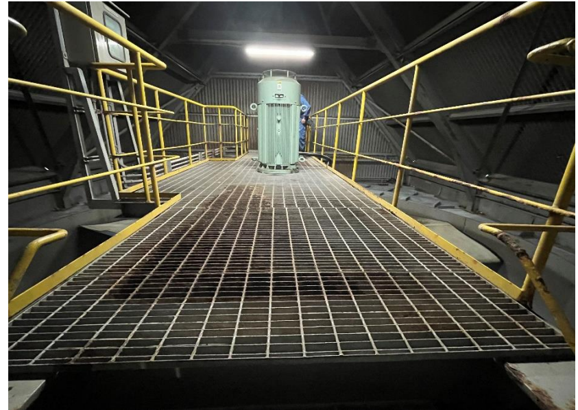
② 内部グレーチング設置状況
